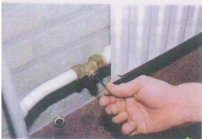
Met behulp van een imbusleutel wordt het ventiel bij de radiator ingeregeld.
